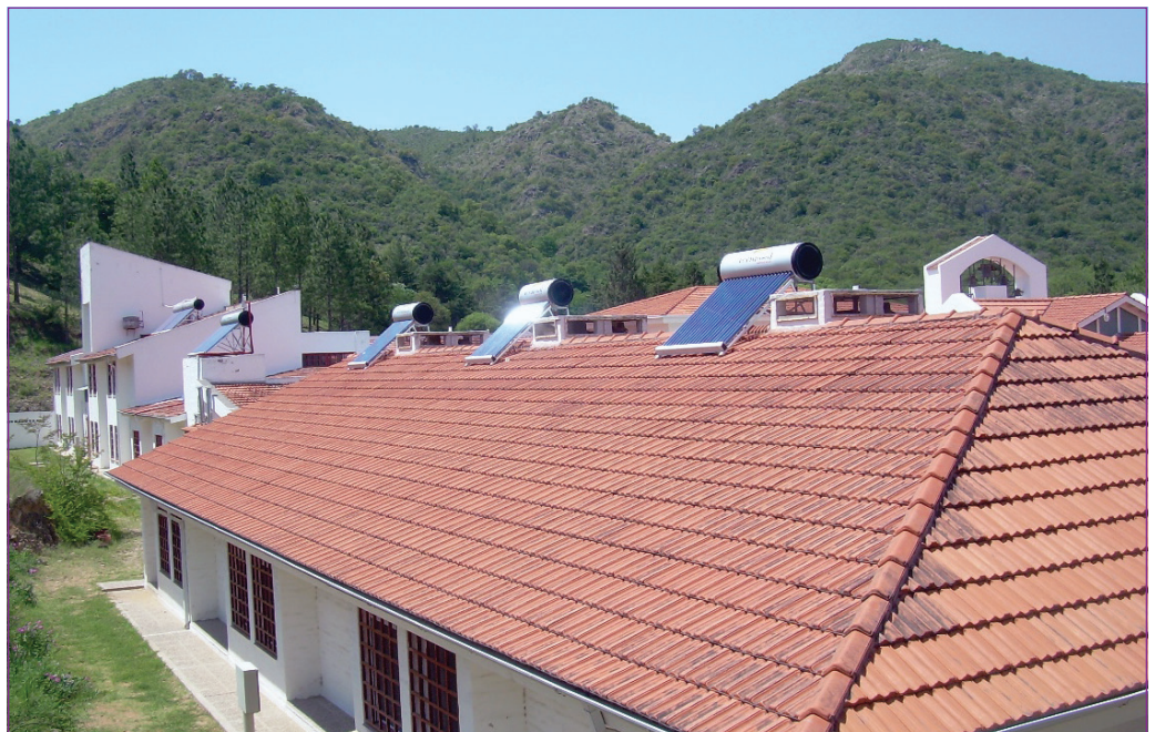
Nos telhados do Mosteiro: equipamentos coletores de energia solar para água sanitária, lavanderia, cozinha e hostelry. Céu limpo e azul claro.
